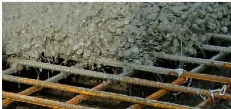
Hình 20 - Bê tông sợi thép trộn kết hợp thanh thép
