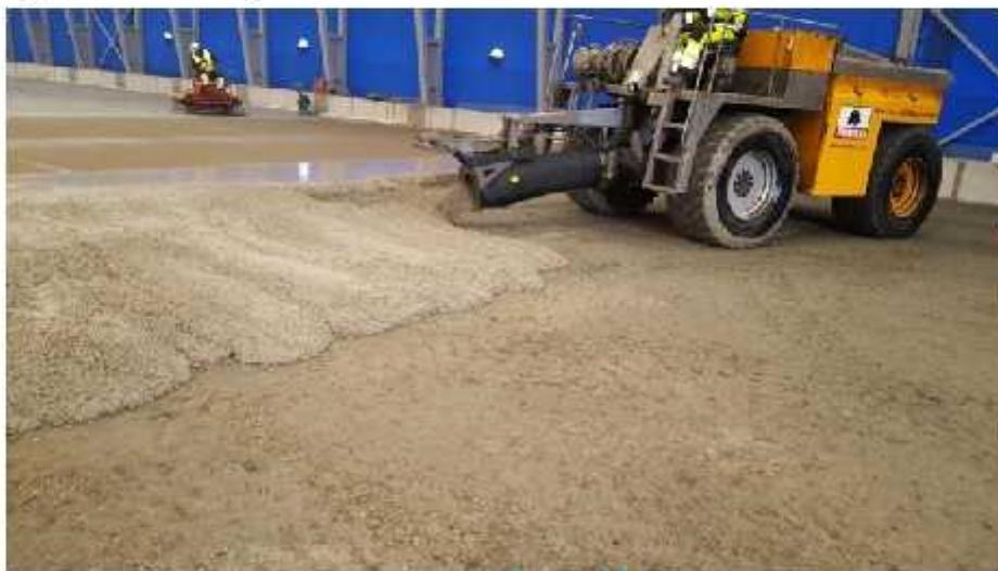
Hình 16 - Nền "không cần khe nối" ("jointless") nhà kho, 38mx38m
