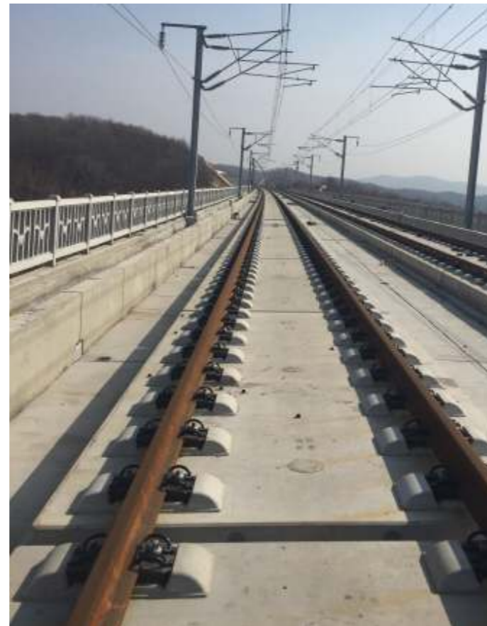
Sàn bê tông đỡ ray đường sắt
