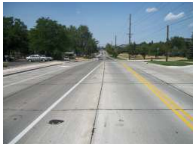
Đường bê tông trộn sợi thép
