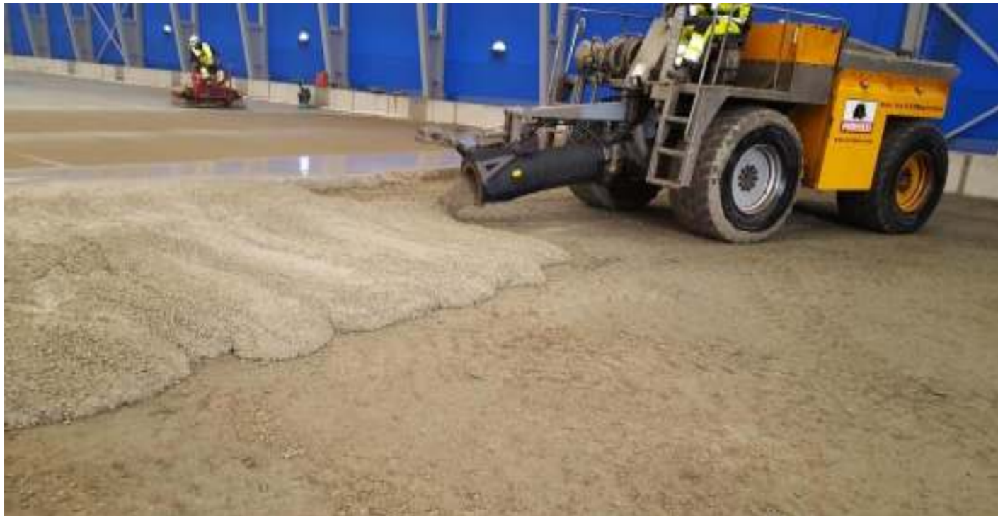
Thi công sàn bê tông trộn sợi thép
