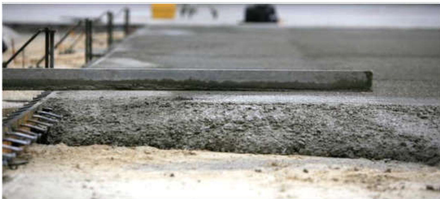
Thi công nhanh hơn với sàn bê tông sợi thép (không có công tác thép thanh)
