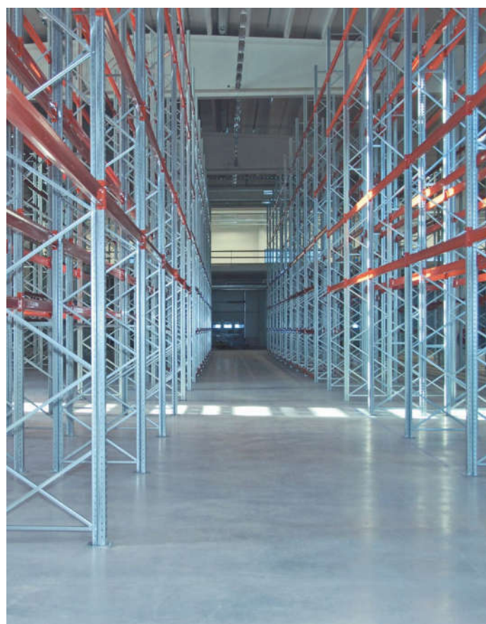
Sàn bê tông đỡ kệ racking
