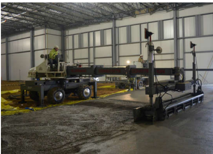
Láng nền bê tông trộn sợi thép
